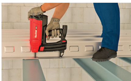
A kompozit lemezek ideiglenes rögzítéséhez acélgerendák esetén
